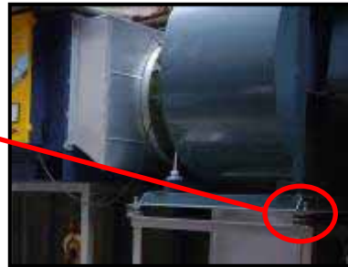
風機底座設置防振墊
