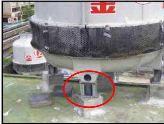
冷卻水塔底座設置金屬彈簧
