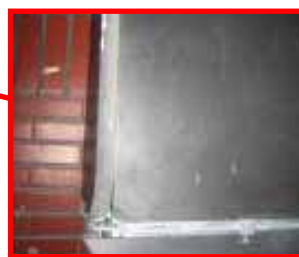
風管以泡棉板包覆
