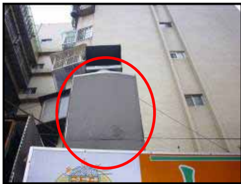
冷卻水塔外設置隔音罩
